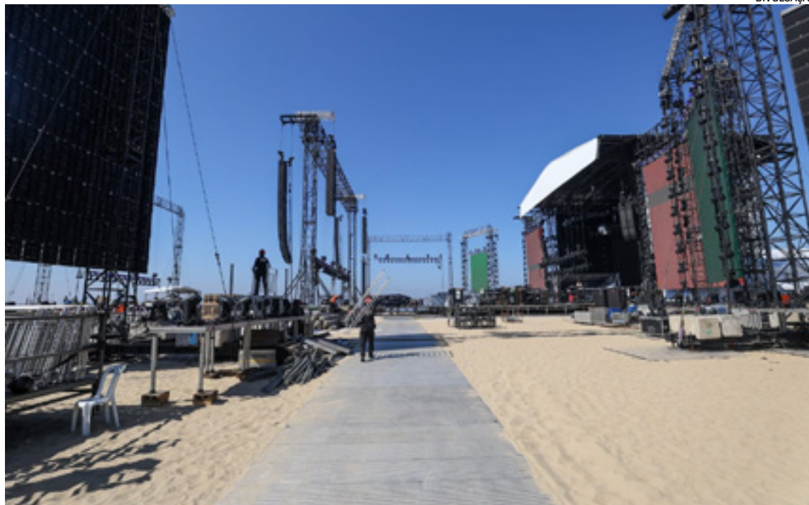
O palco de Madonna sendo montado em Copacabana: estrutura conta com três passarelas e um elevador
